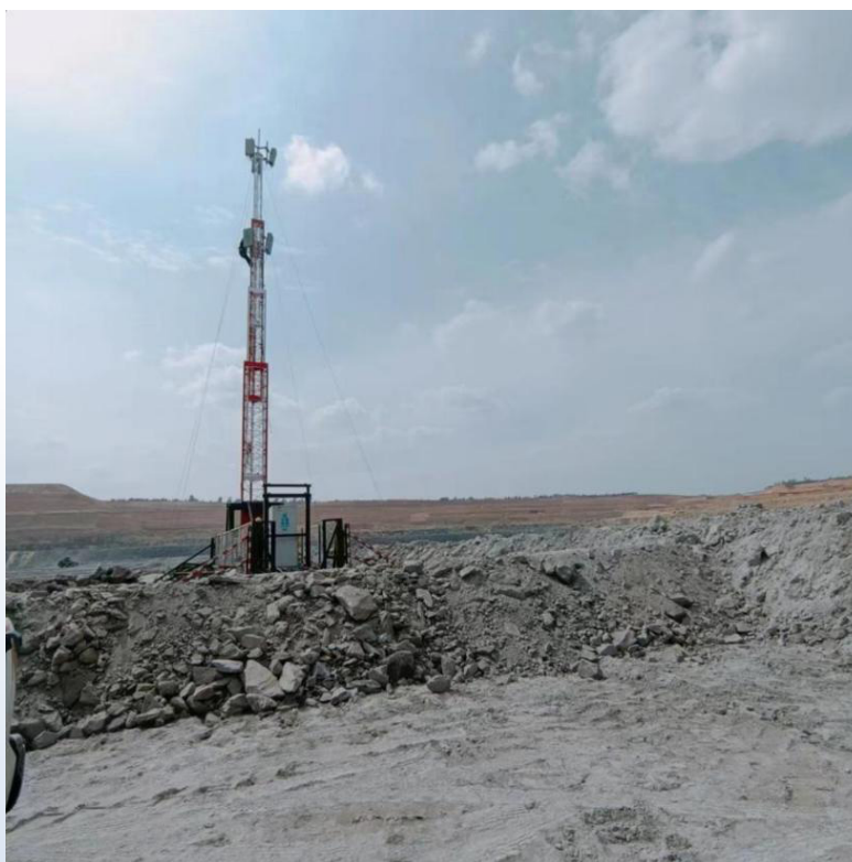
图：升降式集装箱基站（游牧式基站）
